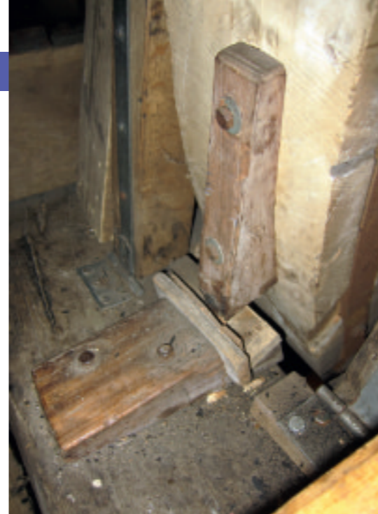
Plankjes in de rust.
