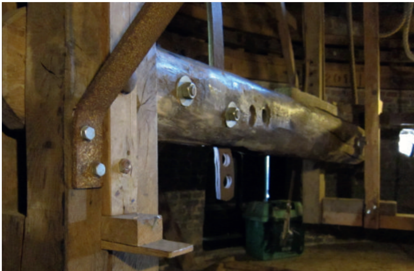
Vangbalk met drie stelpunten: de ezel, het sabelijzer en de vanghaak
