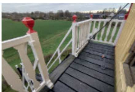
Afb. 3. Traphekje in geopende toestand. Duidelijk is de hoge afstap te zien. Voor kinderen blijkt dit nogal eens een hindernis te zijn.
