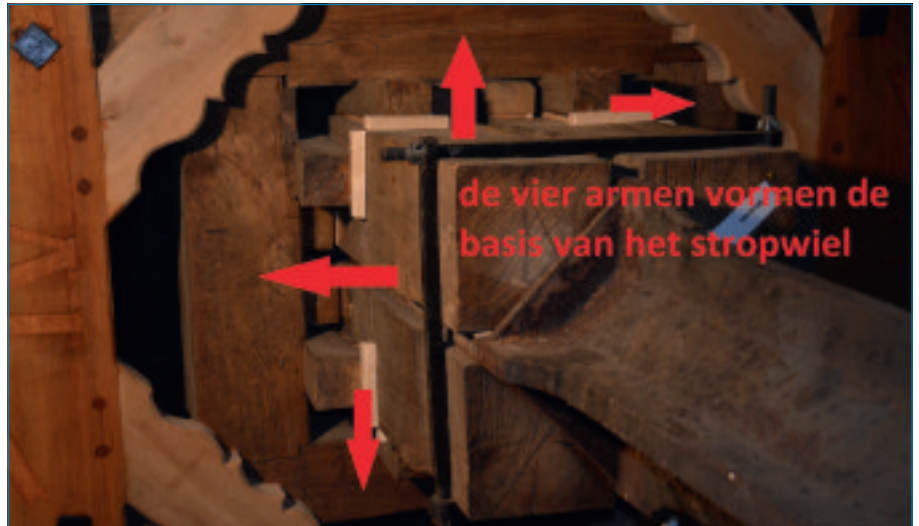
Foto 2. Stroparmen: vier balken liggen als een strop om de vulstukken bij een gietijzeren as uit de Napoleonsmolen Hamont-Achel (Belgisch Limburg).
