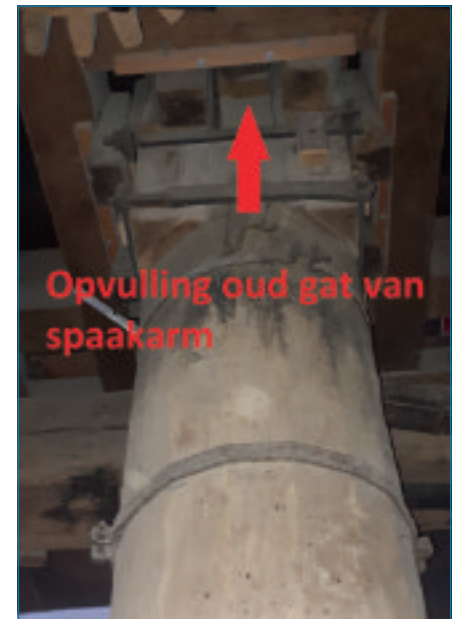
Foto 4. Opvullingen van de gaten van oude kruisarmen uit de Stermolen. De as is rond en ter hoogte van het vangwiel achtkantig. Veel standermolens hebben een ronde as om die ook te gebruiken om met de reep de stenen open te leggen.
