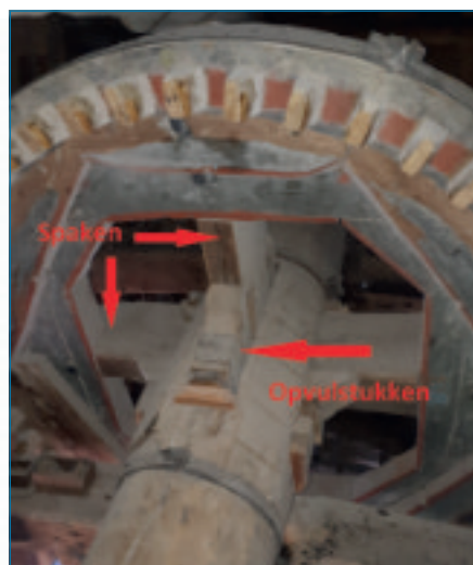
Foto 1. Spaak- of armwiel: twee balken steken kruisgewijs door de as uit de Stermolen Hechtel-Eksel (Belgisch Limburg).
