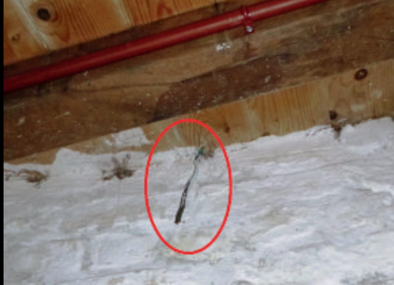
Afb. 2. In de cirkel zie je de bliksemafleider en tegen het plafond de elektriciteitsleiding. De afstand is hooguit 20 centimeter en als de bliksem inslaat geeft dat kans op afslag (vuurwerk).
