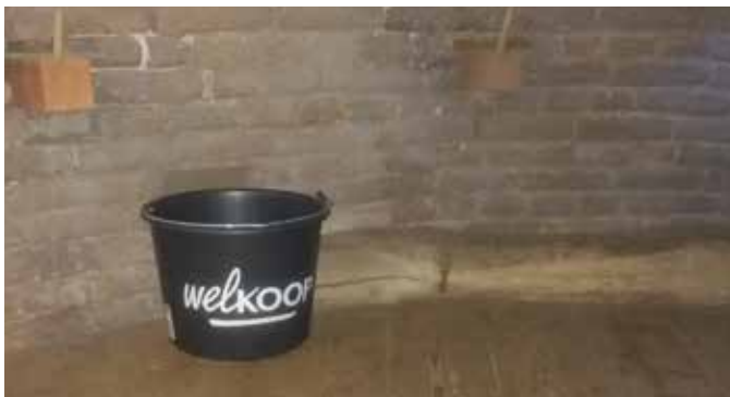
Emmer met water weer in de kap geplaatst
