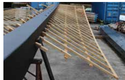
De diepte van de zee is zichtbaar: de drie zoomlatten liggen strak achter of op de hekstocken, de dubbele wafel heeft kortere hekstocken en zoomlatten.
