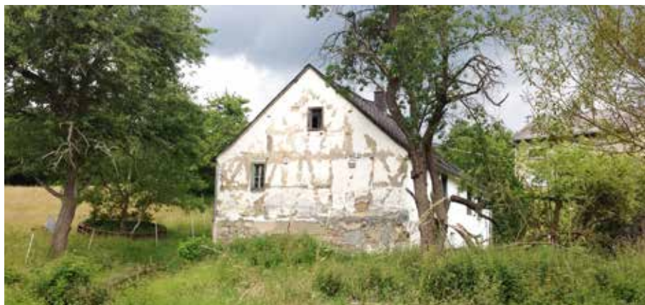
Vakwerk grondig dichtgepoetst
