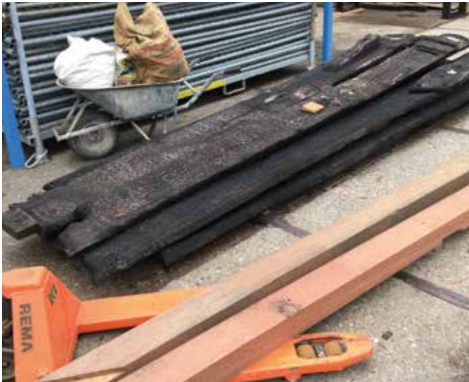
De kokerstijlen hebben erg geleden, maar worden versterkt met staal weer teruggeplaatst.
