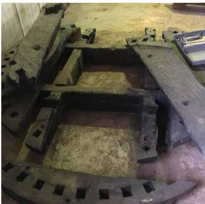
Het oude bovenwiel was niet meer te redden. Een deel is hergebruikt als tafel in de vernieuwde molen.
