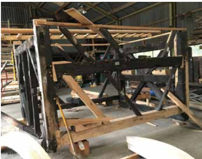
Opvalt hoeveel van het bovenhuis kon worden gehandhaafd. Wel is het bovenhuis beplankt in drie lagen om extra stijfheid aan de constructie te geven. De weegbanden zijn behoorlijk dunner geworden.
