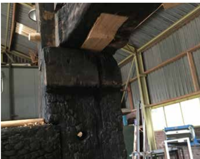
Opvalt hoeveel van het bovenhuis kon worden gehandhaafd. Wel is het bovenhuis beplankt in drie lagen om extra stijfheid aan de constructie te geven. De weegbanden zijn behoorlijk dunner geworden.
