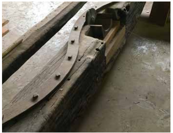
De prachtige kenmerkende versteviging van de penbalk valt direct op. De wolfsbalk heeft op het oog flink te lijden gehad, maar kon klaarblijkelijk toch worden gehandhaafd.
