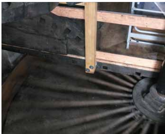
Hergebruik is op alle plekken doorgevoerd. De afgekeurde roeden kregen een tweede leven als balken onder de vloer van de ondertoren.
