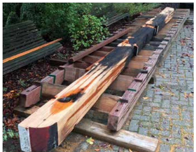
De te handhaven achterzomer met de nieuwe trap. Het verkoolde hout is er afgeschraapt: wat je nu ziet is de resterende zwarte verkleuring van het hout. Dit is uiteindelijk geschilderd. De beschadigingen zijn daardoor nog zichtbaar: ze zijn deel van de geschiedenis van de molen.
