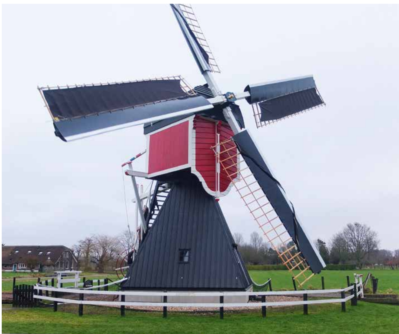
Op 16 december 2017 werd de molen in oude/nieuwe luister opgeleverd en konden de molenaars Arie Harkes en Daan Ottevanger weer aan de slag. De Dekkerwieken zijn donker geschilderd op grond van het historisch onderzoek dat de architect, Erfgoed Advies Groen, heeft uitgevoerd. Oorspronkelijk waren de Dekkerwieken aluminiumkleurig. In de Tweede Wereldoorlog werden ze op last van de bezetter in een schutkleur geschilderd, omdat Engelse bommenwerpers de schittering 's nachts als baken zouden kunnen gebruiken. Na de oorlog is de dekkende kleur gehandhaafd tot het moment dat de Dekkerwieken in 1966 werden verwijderd. De officiële opening volgt later
