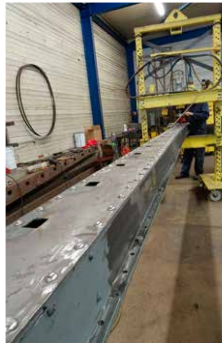
Herstel van de Fransenroede bij de firma Koppes in Nieuw Bergen (L)
