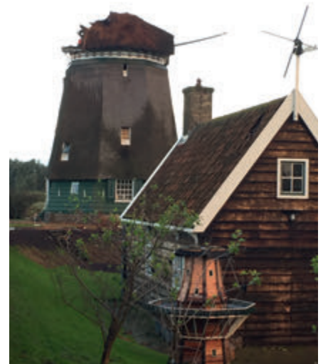
De beschadigde Twiskmolen in Landsmeer
