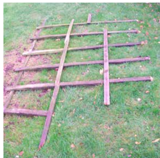
Het afgebroken hekwerk in het gras
