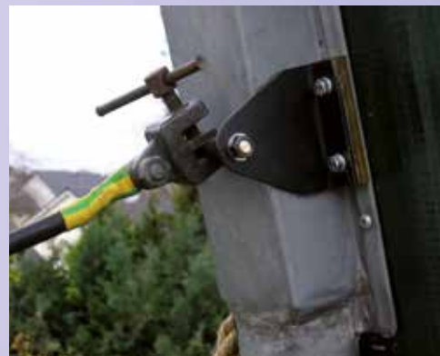
De metalen hemelwaterafvoer aan de staart geaard
