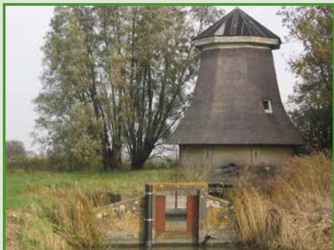
De Slagdijkstermolen bij Oude Leije is in de jaren 1930 getransformeerd tot motorgemaal. Samen met de verderop gelegen Balkendstermolen vertelde dit unieke motorgemaal tot 2007 over de ontwikkeling van de polderbemaling in Friesland. Inmiddels zijn de toevoegingen van het motorgemaal verwijderd en is de molenromp gecompleteerd tot maalvaardige windmolen van een type waarvan er tientallen zijn. Wat is nu nog de onderscheidende cultuurhistorische waarde van deze molen?
