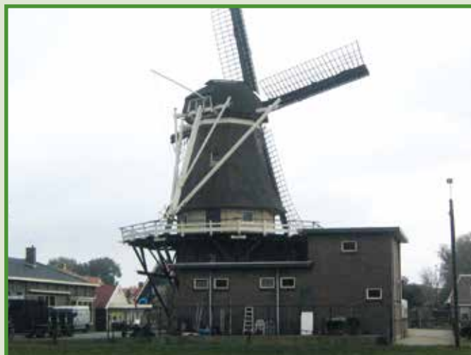
Molen De Mars in De Blesse. De onderbouw van een vroegere korenmolen was verbouwd tot een maalderijcomplex. Op de onderbouw is in 1997 een houten achtkant geplaatst van een poldermolen en een molenkap uit Duitsland. De Mars is vernoemd naar de huidige eigenaar. Deze in 1997 gevormde molen is ondanks de afwezigheid van een historisch gegroeide betekenis aangewezen als rijksmonument. Is dat bij molens als deze terecht?
