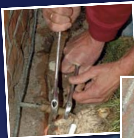
Het losmaken van de aardelektrode nr. 1 gaat niet vanzelf
