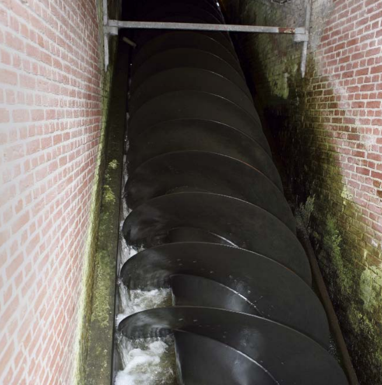
De vijzel van 12 meter lengte heeft een diameter van 1.34 cm
