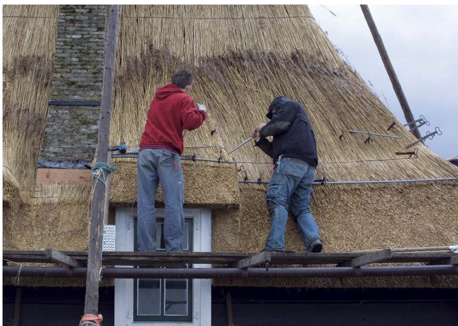
Het rietdek loopt bij zo'n wipmolen steil omhoog
