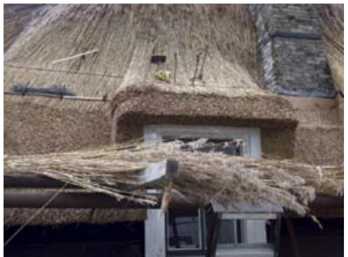
Gereedschap van de rietdekkers. Rechts zie je de gemetselde schoorsteen
