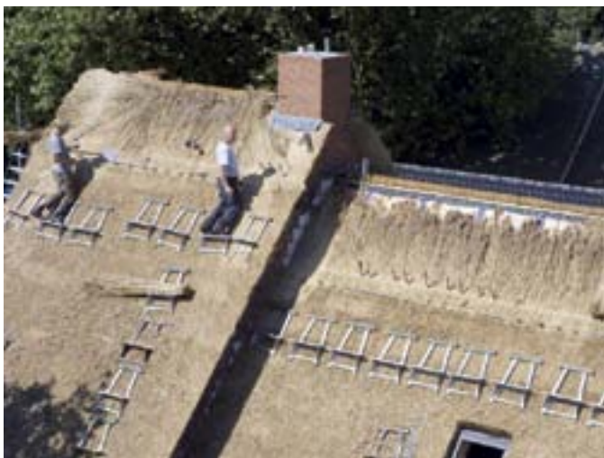
Boerderij in Oud Ade, de gebroeders Visser overleggen op het dak
