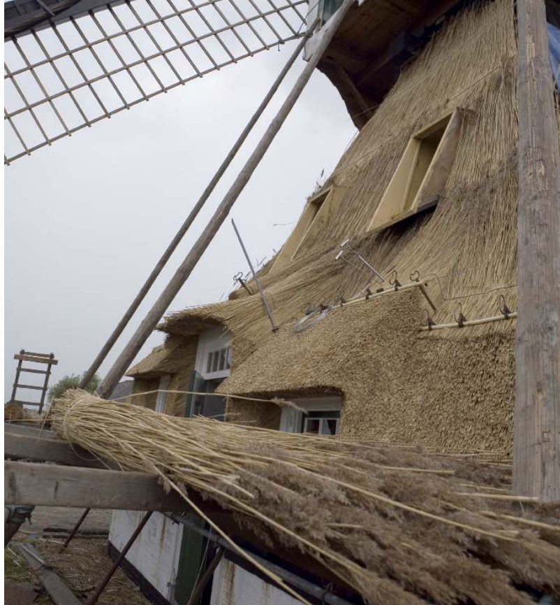
Er wordt prachtig boven de deur en de ramen gedekt
