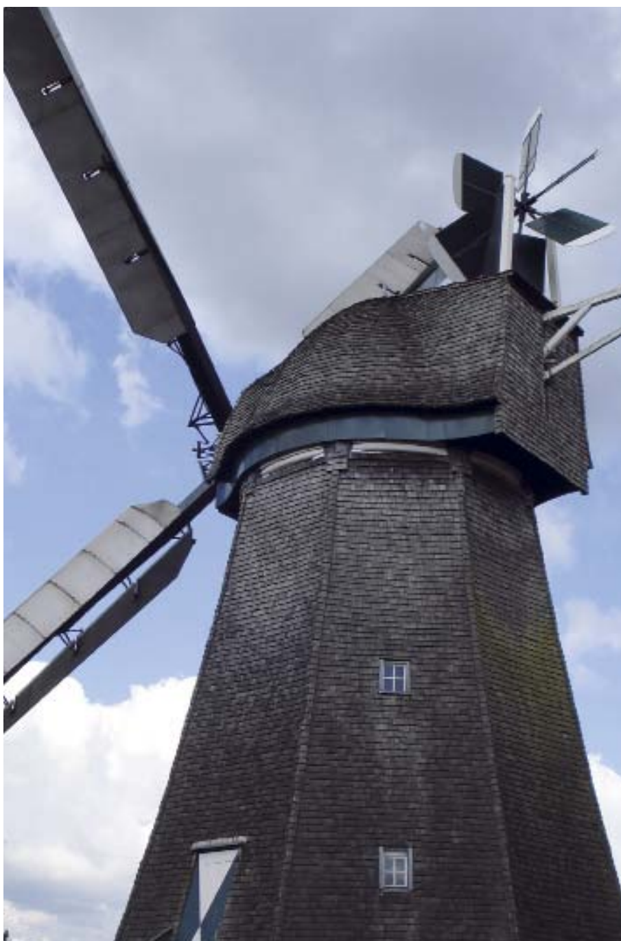
Molen met zelfkruisysteem op de kap
