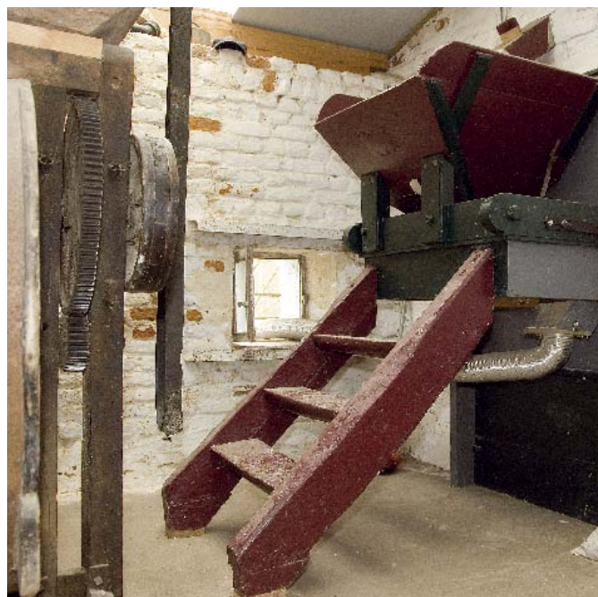
Kaar van de schoonder boven aan de trap
