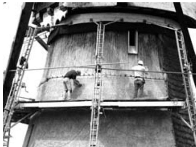
De molen wordt voorzien van een nieuw rietdek.
