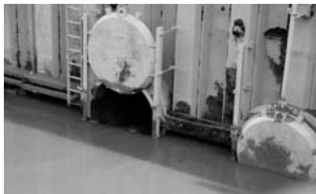
De sluiskleppen in de afsluiting tussen de spaarkom en de Schelde.
