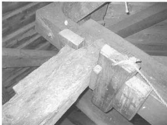
De blokkeerwig voor de tapbalk van de steenspil.
