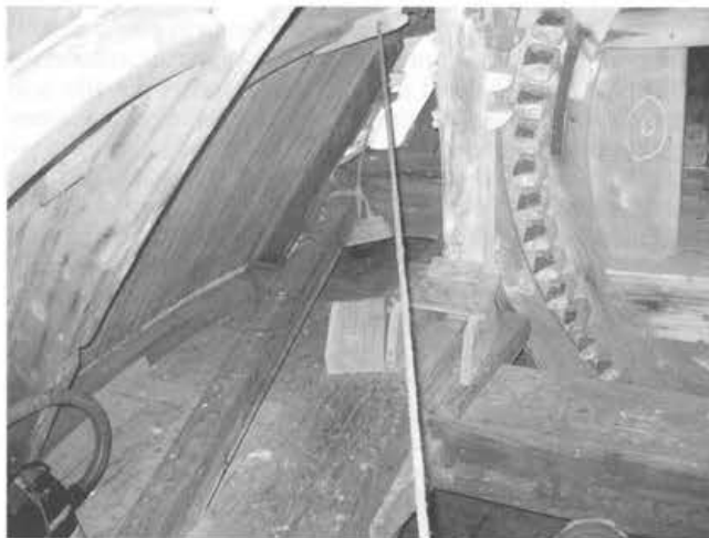
Goed is te zien de schuin naar de spruitbalk lopende steunbalk.
