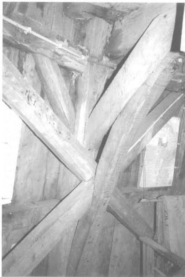
Afb.2 Het zestienkant in Horn L. De slappe veldconstructie is versterkt met extra veldkruisen en korbelen.
