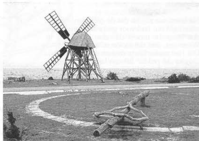
De windsteenslijpmolen van Jordhamn met op de voorgrond de met diertractie voortbewogen slijpstenen.
