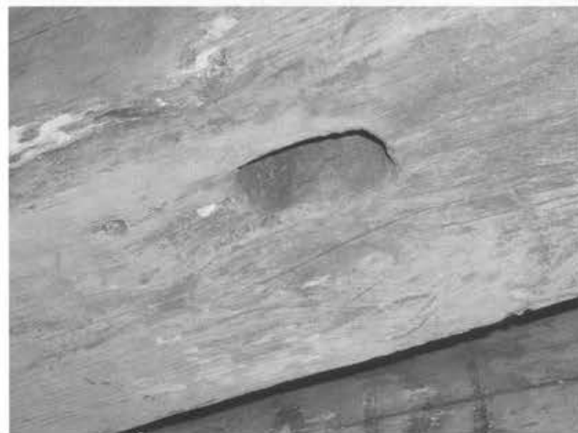
Afb.2 Een van de hekstockgaten in de vloerbalken ofwel restant oude roede.
