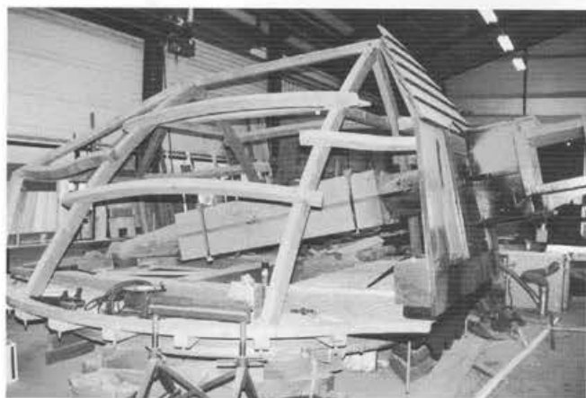
Nieuwe molenkap in de werkplaats van molenmaker Verbij te Hoogmade, een mooi voorbeeld van molenmakerswerk.
