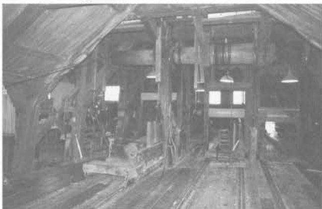
Een indrukwekkend kijkje over de zaagvloer van "De Rat", met drie zaagragen.
