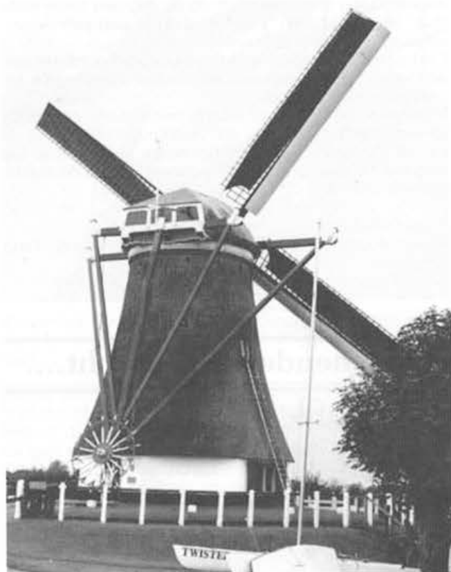
De Veendermolen, te Alkemade, een wat bouw betreft een bijzondere molen. Gebouwd in de vorm van een achtkant maar met een ronde doorsnede. Een relatief jonge molen gebouwd in 1934.
