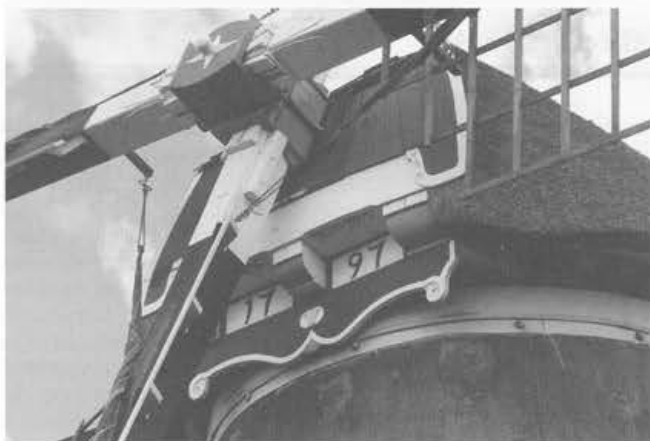
De gerepareerde roeden met schetsplaten op het askop deel. Let eens op de verzorgde afwerking, in één woord vakwerk.
