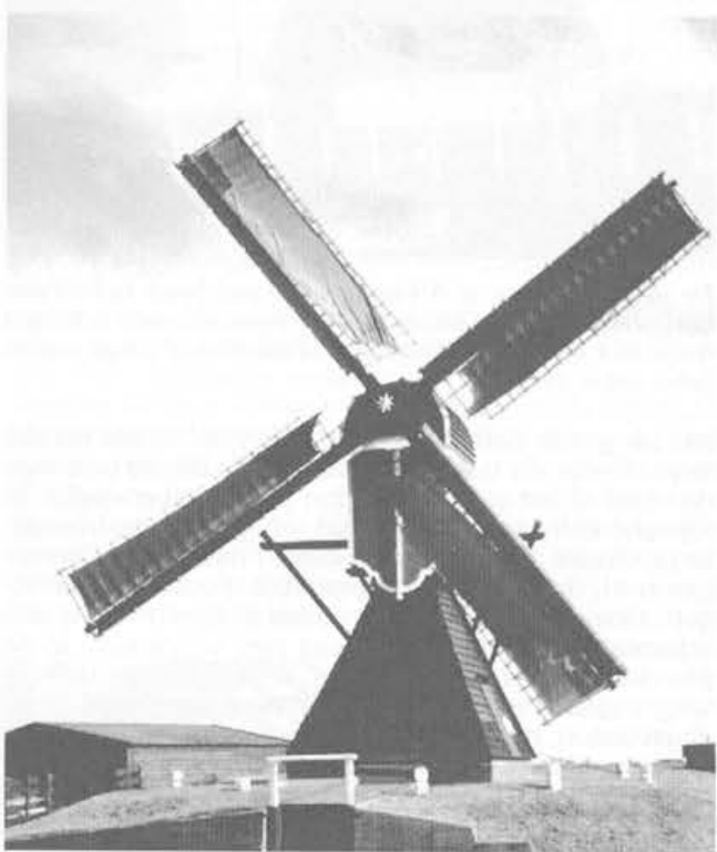
De Zweilander molen, een wipmolen met een vlucht van 17,40 m. gebouwd in ca 1632 en natuurlijk zoals gebruikelijk in deze streek met een fraaie rode kop.
