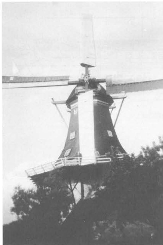
De kloppen in bedrijfstand, dus klaar voor vanglichten
