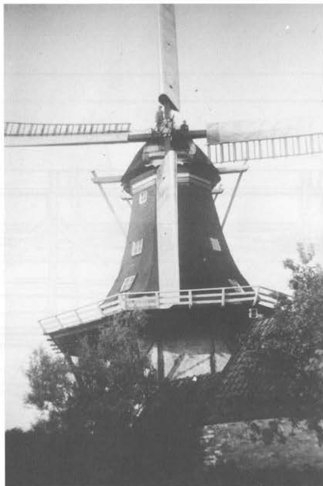
De kleppen in ruststand, dus gestopt en gevangen
