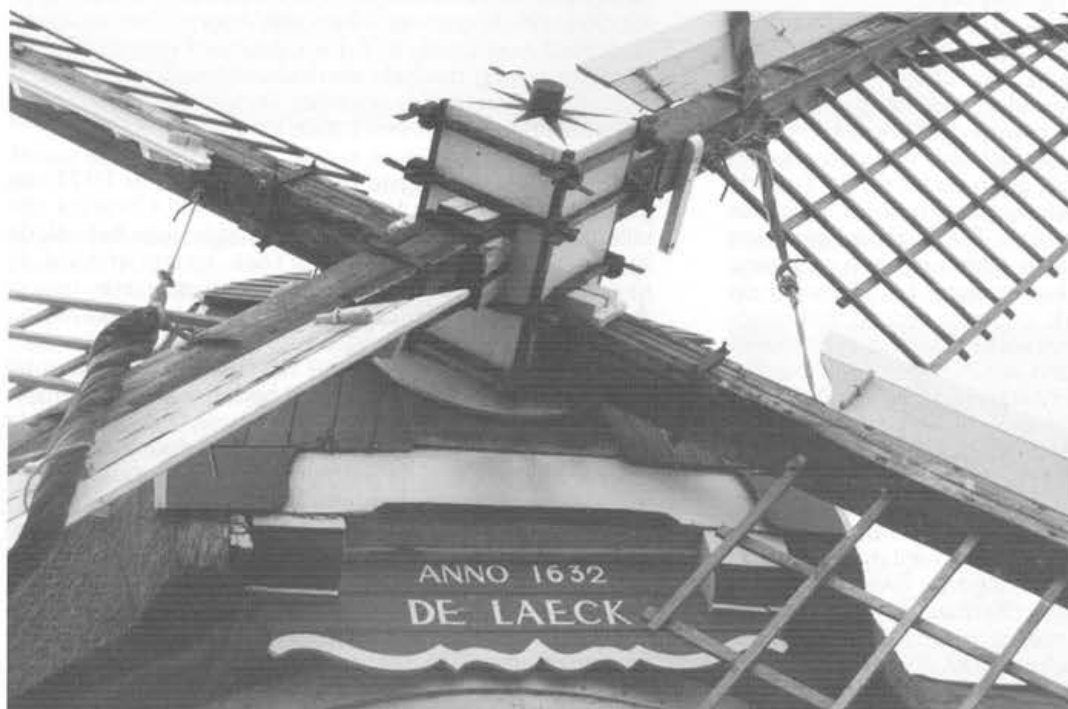
Het houten gevlucht van de Lakermolen, een ronde stenen grondzeiler uit 1818. Als bijzonderheid nog uitgerust met een houten gevlucht.
