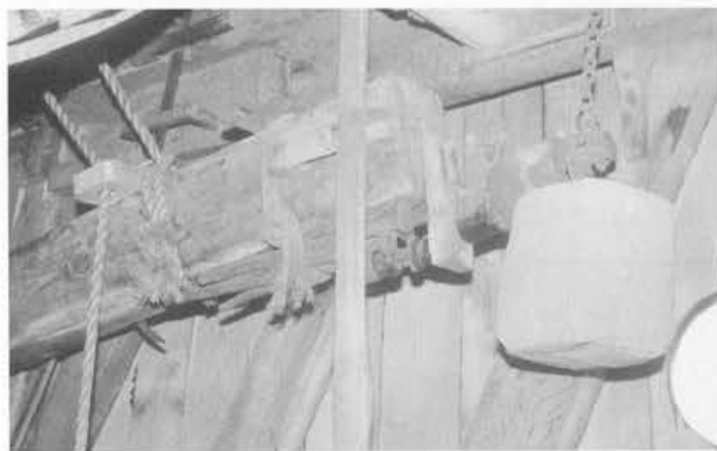
Het op originele wijze verzwaarde achtereind van de vangbalk.
