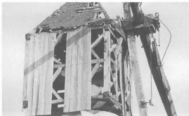
Thouarcé, 1973. "Moulin de la Montagne". Dunne hoekstijl. Twee hondsoeren tegen de spoorstijlen onder de windpeluw. Houten bovenas; houten tweedelige roeden met de resten van het Bertongevlucht. (Foto's archief SMD)
