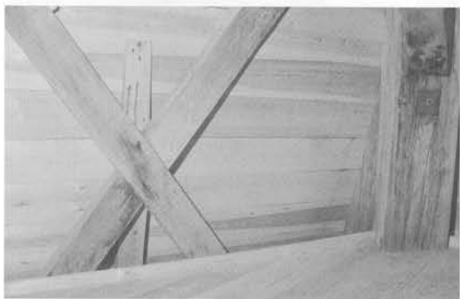
De vloer is tegen de veldkruisen aangelegd en vrij van het zeskant.
