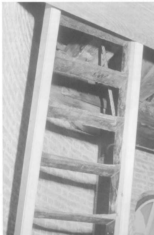
De trap met de verstevigde trapbomen
