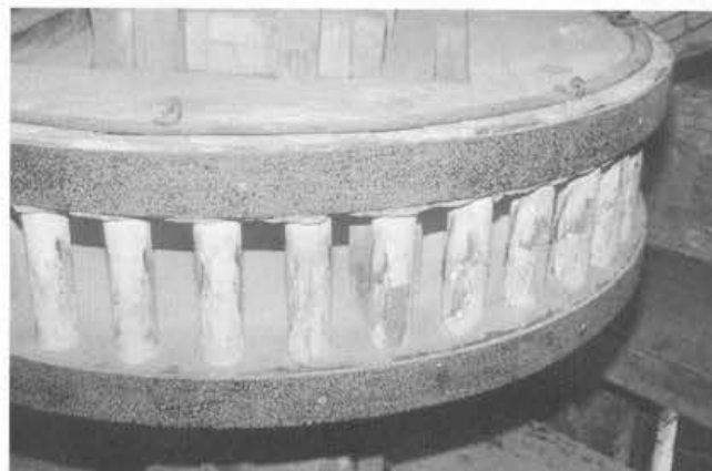
De staven van de bovenschijfloop zijn alle schietstaven.
