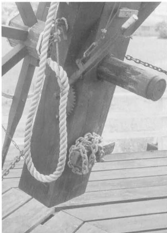
De bedieningshandel van de Van Rietkleppen op de staart.
