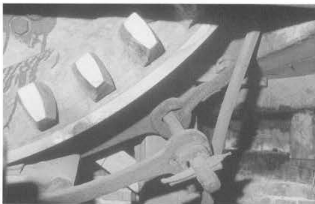
Slechts één koebout vormt de bevestiging van het buikstuk van de vang aan het rechtervoeghout.
