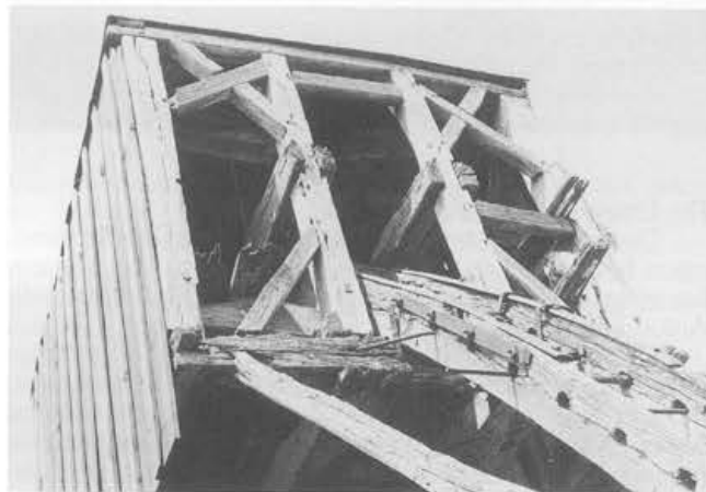
Grézille, 1973: "Moulin Tracas". Tussen de achterzomer en de (dunne) wolfsbalk zien we twee spoorstijlen, die in de uiteinden van de steenburriebalken zijn gewerkt. In tegenstelling tot onze wipmolens ligt in de Franse wippen de steenburrie evenwijdig aan de voegburrie.
