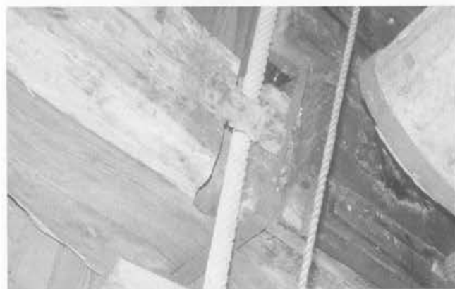
Het penlager met ter weerszijden daarvan het gaffeltouw, waarvoor sleuven in de penbalk zijn gefreesd.
