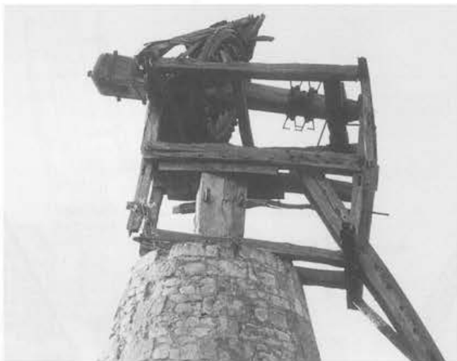
St. Georges de sept voies, 1972. "Moulin l'Echaudiet" legt het loodje. Zeer lichte constructie van het skelet. De trapbomen rusten op de achterzomer en lopen door tot in het bovenhuis, waar ze aan de steenburrie hangen. Daarom is een staartbalk overbodig. Achter op de bovenas is de bediening van het voormalige Bertongevlucht zichtbaar. (Foto Archief SMD).
