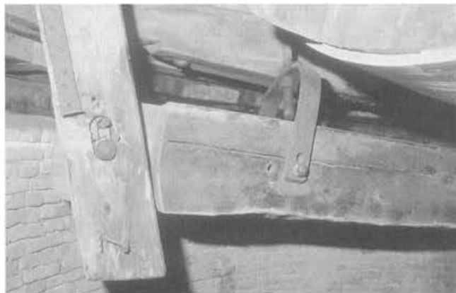
De uitzonderlijke bevestiging van het sabelijzer aan de vangbalk.
