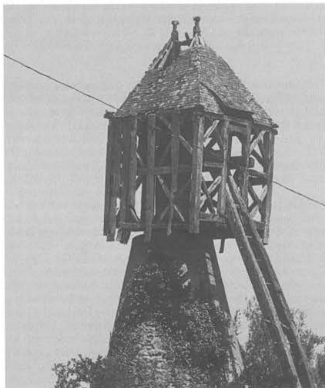
Chavagnes, 1973: "Moulin des Gauliers", een 'cavier' van later datum, die geheel bovengronds is gebouwd. Het kleedhout is reeds verdwenen, waardoor de (lichte) constructie van het bovenhuis zichtbaar is geworden (foto Archief SMD).
