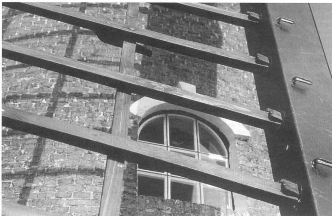
De speciale zwichtlijnklamp in het hekwerk (links boven het venster) van de molen te Nieuwvliet
