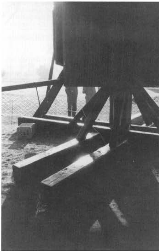
afb. 1 Vier kruisplaten en acht - enkele - steekbanden.
