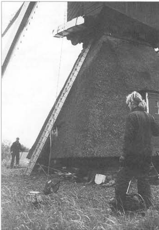
De oude windpeluw (van de Westerveense molen) hangt hier niet via één, maar via twee handtakels aan twee kruipalen. De ladder, waar hij langs zal schuiven, beschermt het riet.
