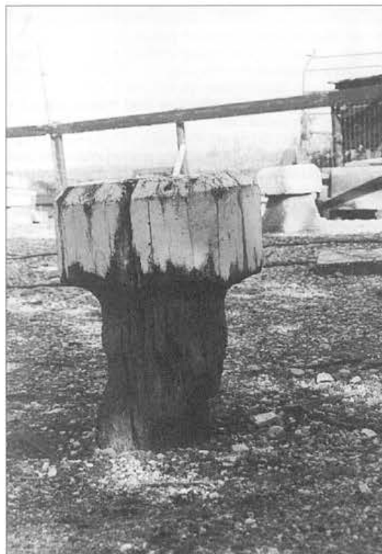
Kruipaalkop, die z'n dienst bewezen heeft. Hij is vernieuwd vóórdat een storm z'n kop afrukte.
