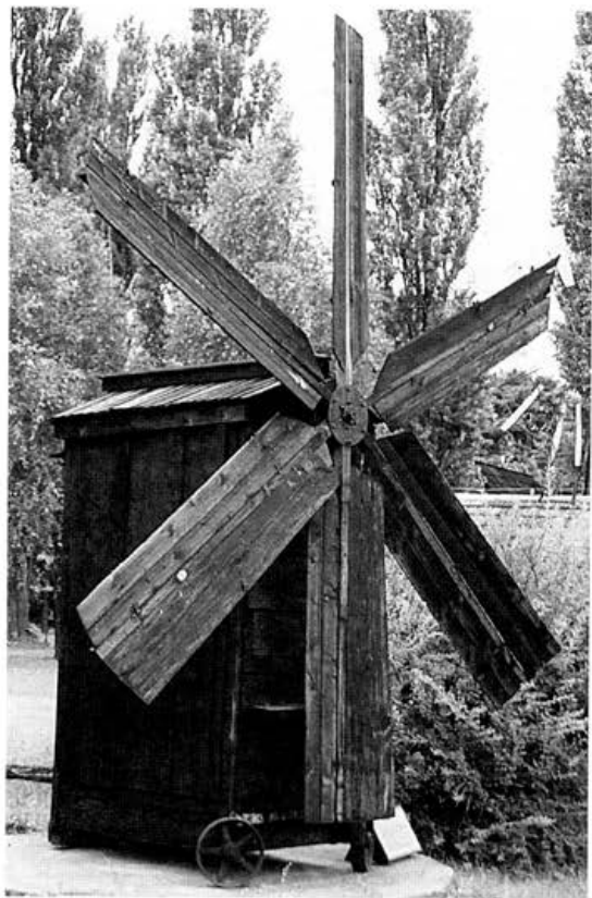
afb. 5 Boerenmolentje, aangetroffen in een museum van landbouwtechnieken, bij Poznan in Polen. Gevlucht ca. 3\frac{1}{2} m. Verplaatsbaar en simpel op de wind te zetten. In de kast een maalkoppel van ca. 50 cm diameter. Het gevlucht draait normaal, linksom (gezien uit de richting van de fotograaf). Een soortgelijke "handmolen op windkracht" zou misschien een directe voorganger van de standermolen geweest kunnen zijn.
