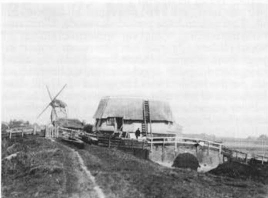
Afb. 4 Moerkapelle, 1925, de Rottekade. Tot stomp gesloopte molen no. 3 van de viergang schepradmolens. De waterloop ligt, van de pol- der gezien, rechts! Erachter staat molen no. 4, de bovenmolen, op het punt ook tot stomp gesloopt te worden.
