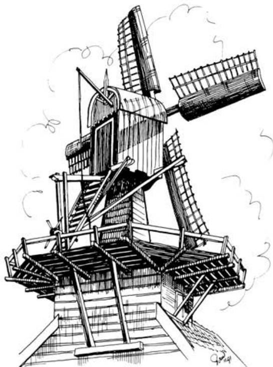
HET DOOR A.J. DEKKER IN 1915 GEBOUWDE LATTENZAGERTJE TE HAZERSWOUDE DORP. VLUCHT 7,00 m.
